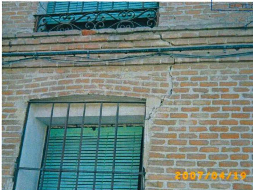
FOTOGRAFÍA nº 2: Detalle de ventana en planta baja: rotura de la fábrica de ladrillo que une los huecos de las dos plantas. Jambas y dintel del hueco enfoscados.
